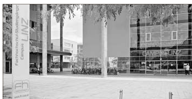
Moderne Infrastruktur und kurze Wege kennzeichnen den Campus Linz der FH Oberösterreich. (Foto: FH Oberösterreich)
